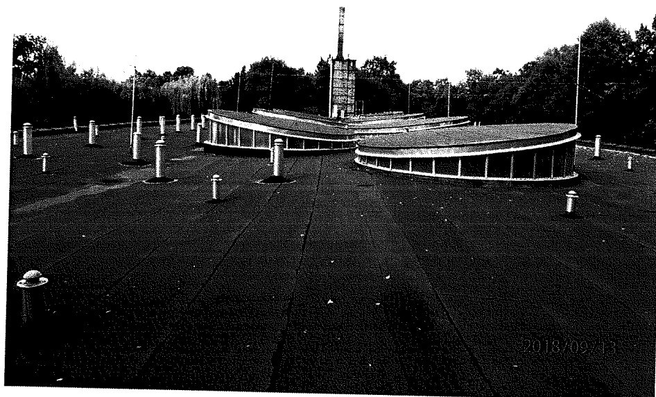
Fot. 1. Ogólny widok dachu pawilonu Akwarium i Herpetarium. Zdjęcie wykonane z kierunku wschodniego. Widoczne liczne wywietrzniki przechodzące przez dach stanowią potencjalne źródło przecieków.
