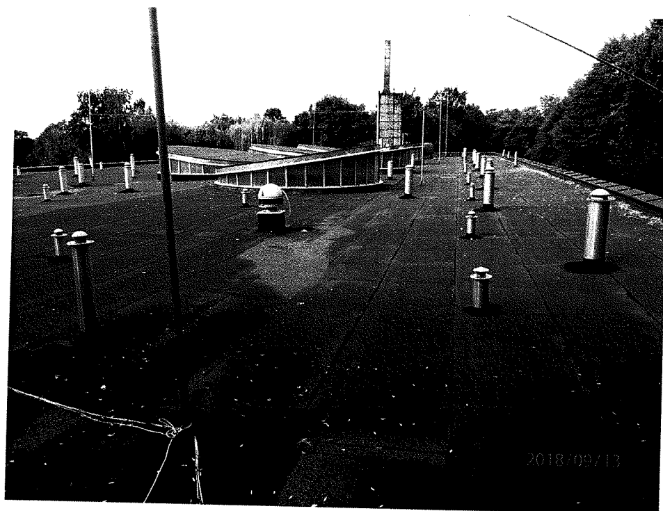
Fot. 2. Inne ujęcie pokrycia papowego na dachu pawilonu Akwarium i Herpetarium. Niewielkie ślady po zastoiskach wody opadowej wskazują na konieczność poprawy spadków dachu.
