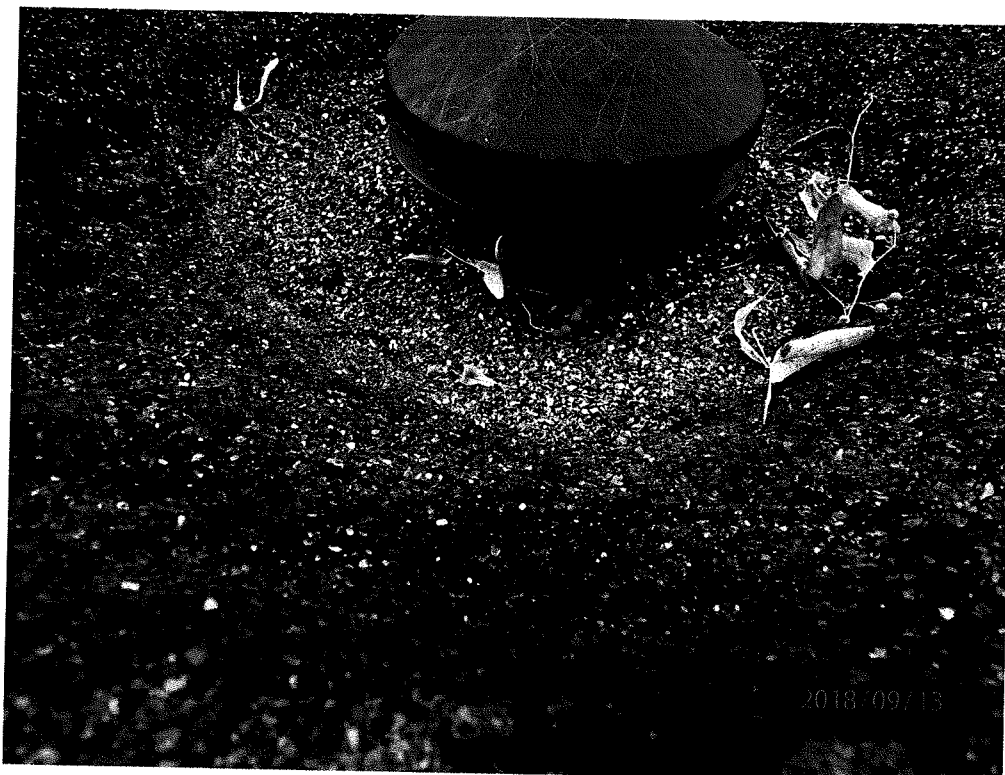
Fot. 38. Zaleganie liści i posypki łupkowej z papy może doprowadzić do zapchania odpływu wód opadowych
