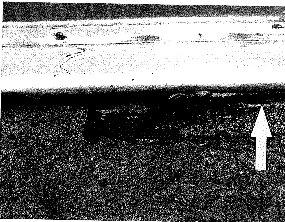
Fot. 28. Usterki izolacji ścianki kolankowej świetlika. Strzałka czerwona pokazuje uszkodzenie mechaniczne papy, strzałka żółta – odpajanie papy od ścianki kolankowej. Są to przyczyny penetracji wody opadowej.
