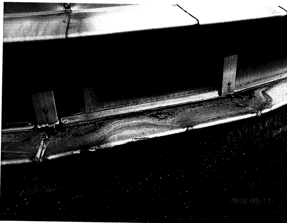
Fot. 22. Ślady długiego zalegania wody opadowej na dolnej obróbce blacharskiej świetlika z powodu zbyt niskiej ścianki kolankowej oraz złego spadku blachy.
