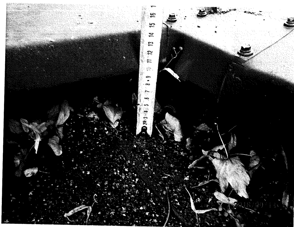
Fot. 4. Narożnik południowo-wschodni attyki. Widoczna zbyt mała wysokość ścianki pionowej uniemożliwiająca wykonanie prawidłowej obróbki z papy (minimalna wysokość powinna wynosić 10 – 15 cm). Źłe wyprofilowane zakończenie obróbki blacharskiej.
