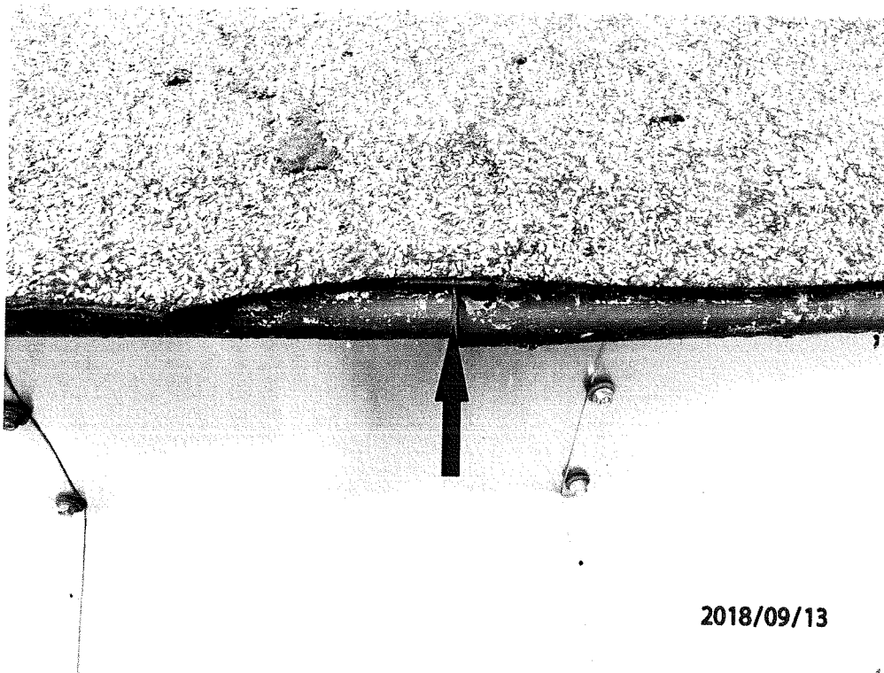
Fot. 25. Inne miejsce braku ciągłości obróbki blacharskiej.
