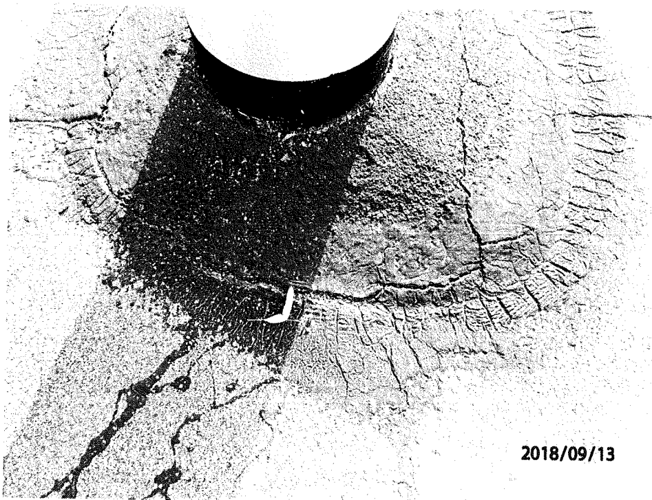
Fot. 13. Typowa usterka pokrycia z papy w miejscach przechodzenia wywiewzaków przez dach – prawdopodobna przyczyna nieszczelności pokrycia. Pęknięcie pokrycia z papy wskazuje na niską jakość użytego tego materiału. Nieprawidłowo wykonana obróbka wywiewki.
